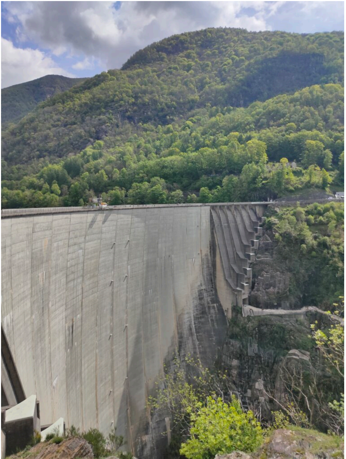
Staumauer Golden Eye
